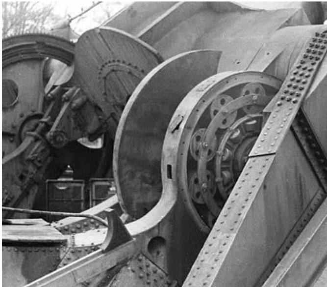
Blick in eins der geöffneten Deklinationsrollenlager (Foto: Archiv Archenhold-Sternwarte)
