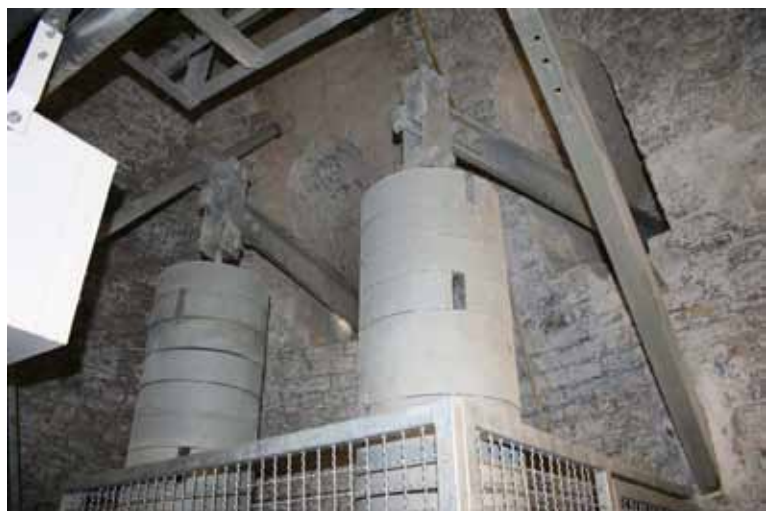
Im Fundamentinnern die tragenden Gegengewichte des Nordlagers (Foto: Eckehard Rothenberg)
