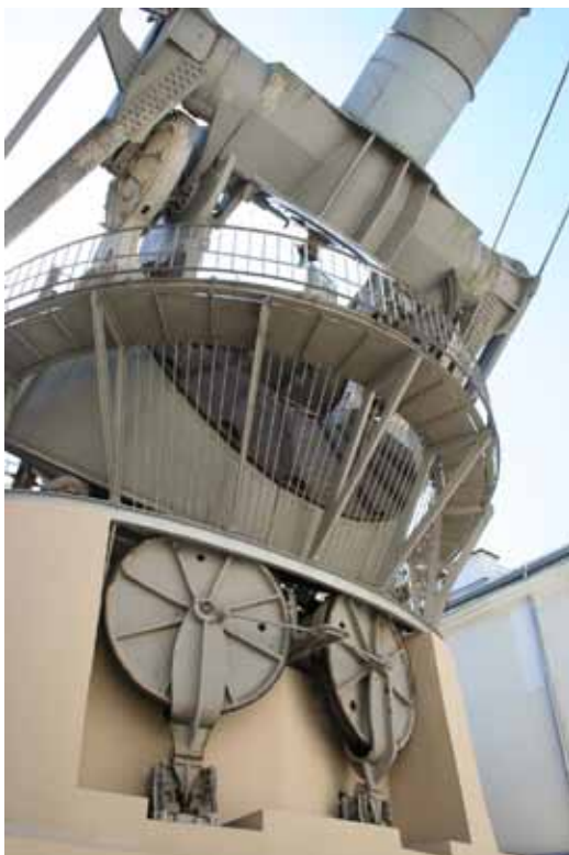
Die großen Rollen des Nordlagers (Foto: Eckehard Rothenberg)
