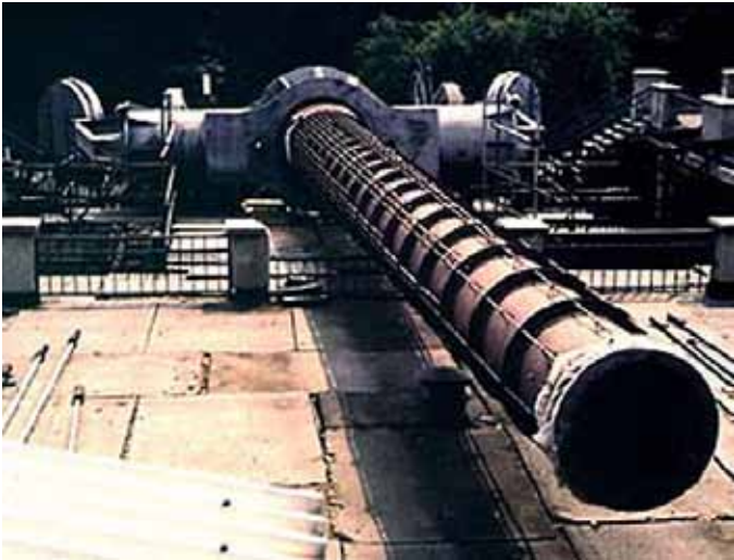
Der innere Rohrtubus und das Kompensationssystem gegen die Rohrdurchbiegung (Foto: Nikolai Wünsche)
