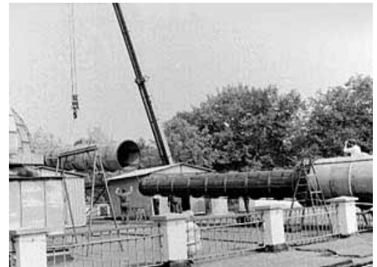
Montage der zweiten Tubushälfte (Foto: Archiv Archenhold-Sternwarte)
